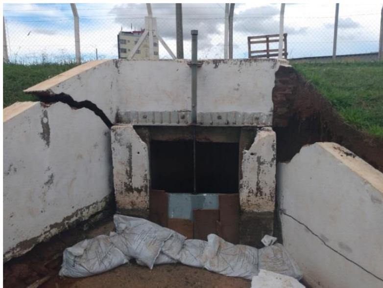
Figura 4-2 – Condição atual do vertedouro
