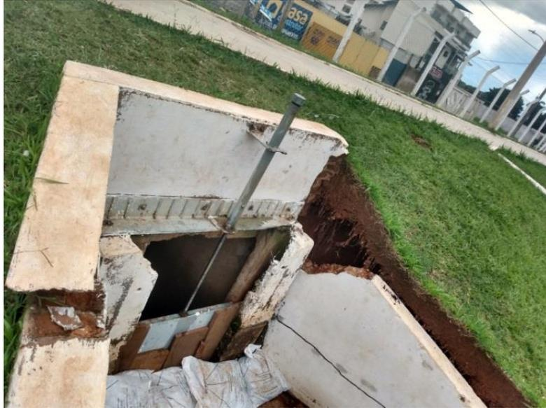
Figura 4-1 – Condição atual do vertedouro
